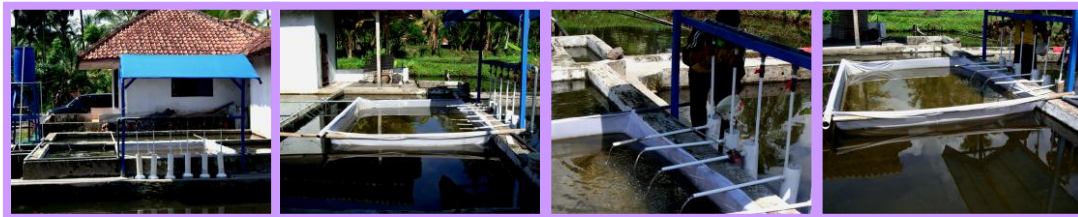
Sistem penetasan telur dengan Mcdonal jar/ sistem corong yang dimodifikasi, sistem air resirkulasi dan menggunakan filter biologis.
